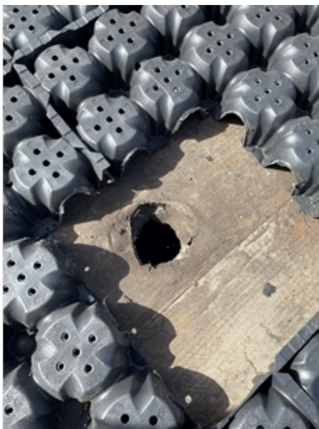
Figura 4.2 – Foro di scarico acqua piovana.
