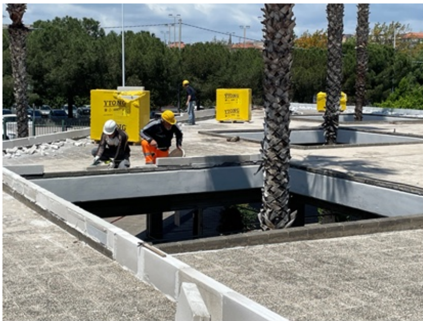
Figura 4.4 - Progetto GFLUID, Dipartimento di Agricoltura, Alimentazione e Ambiente, – Catania. Costruzione cordolo.
