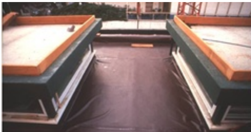
Figura 3.3 - Guaina antiradice saldata a freddo
