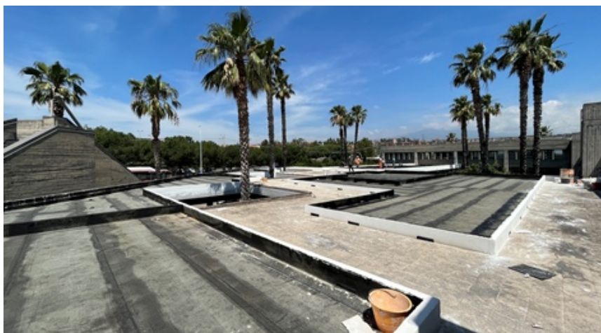
Figura 4.5 - Progetto GFLUID, Dipartimento di Agricoltura, Alimentazione e Ambiente - Catania. Posa in opera guaina antiradice.
