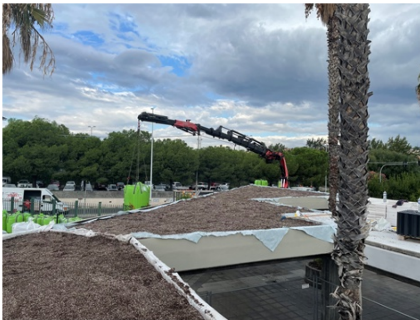
Figura 4.9 - Progetto GFLUID, Dipartimento di Agricoltura, Alimentazione e Ambiente - Catania. Posa in opera terriccio alleggerito
