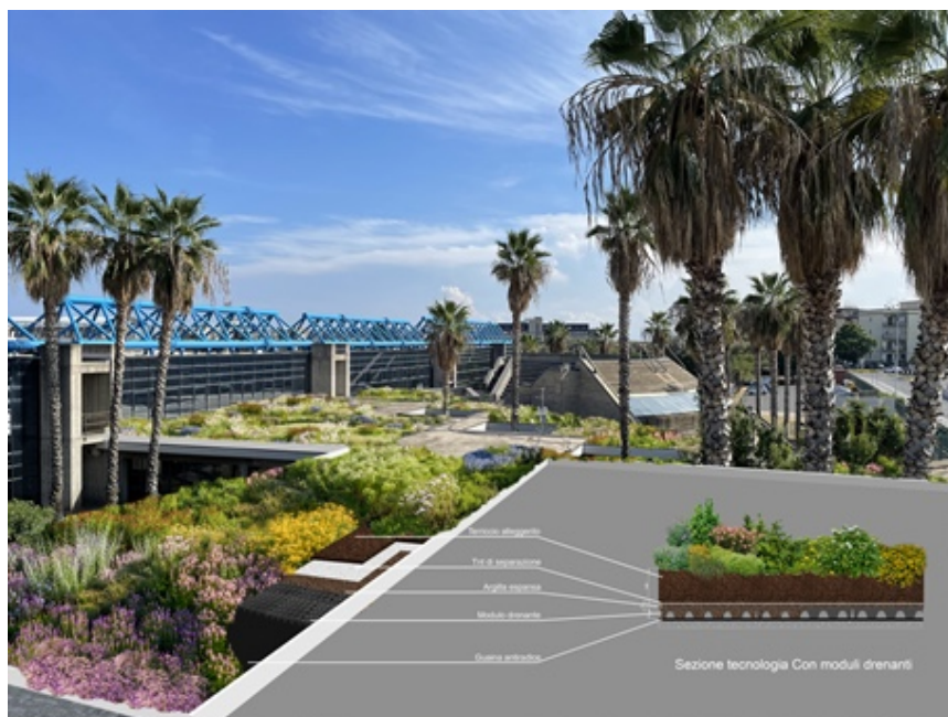
Figura 3.8 - Esempio della stratificazione di un giardino pensile –progetto GIFLUID, Dipartimento di Agricoltura, Alimentazione e Ambiente - Catania
